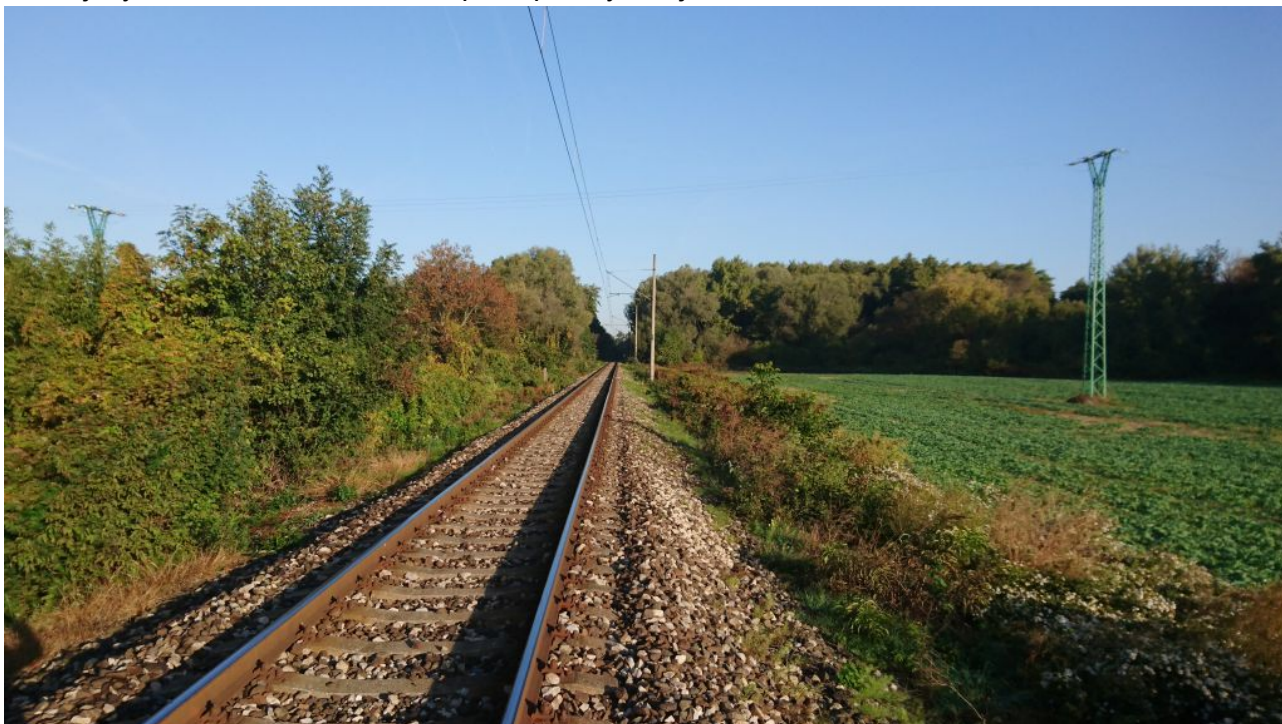
Obrázok 5 Pohľad na železničnú trať vedenú centrálnou rovinatou časťou aluviálnej nivy so zarastenými a zamokrenými priekopami
