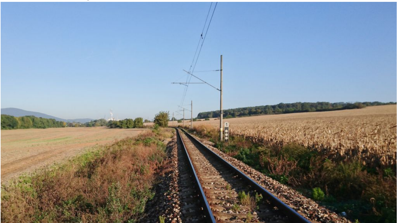
Obrázok 7 Železničná trať v úseku žkm 12,500 – 13,600, vedená okrajom alúvia potoka Trnávka. Pravostranný svah je zdrojom pritékajúcich povrchových i podzemných vôd, pričom teleso železnice predstavuje bariéru pre prirodzené odvodňovanie územia.
