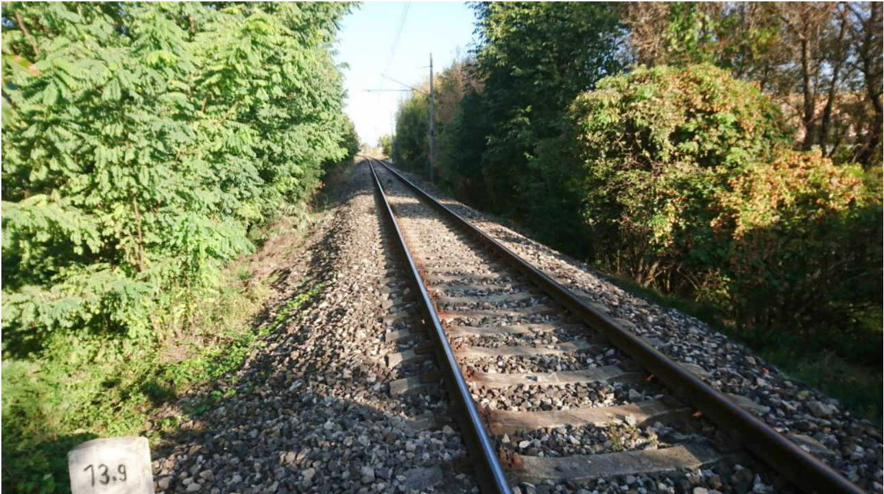
Obrázok 8 Spätný pohľad (smerom na Šelpice) na úsek železničnej trate vedený na násype cez terénnu zníženinu bezmenného potoka. Svahy násypu sú porastené náletovými drevinami (agát, orech).
